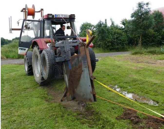
Demonstration der Vorbereitungen für die selbstorganisierte Verlegung eines flächendeckenden Glasfasernetzes in Hamminkeln-Loikum
