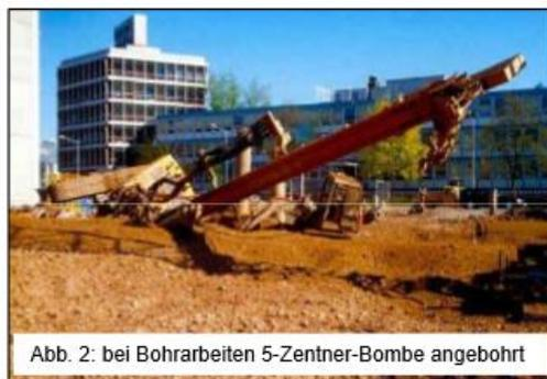
Abb. 2: bei Bohrarbeiten 5-Zentner-Bombe angebohrt
