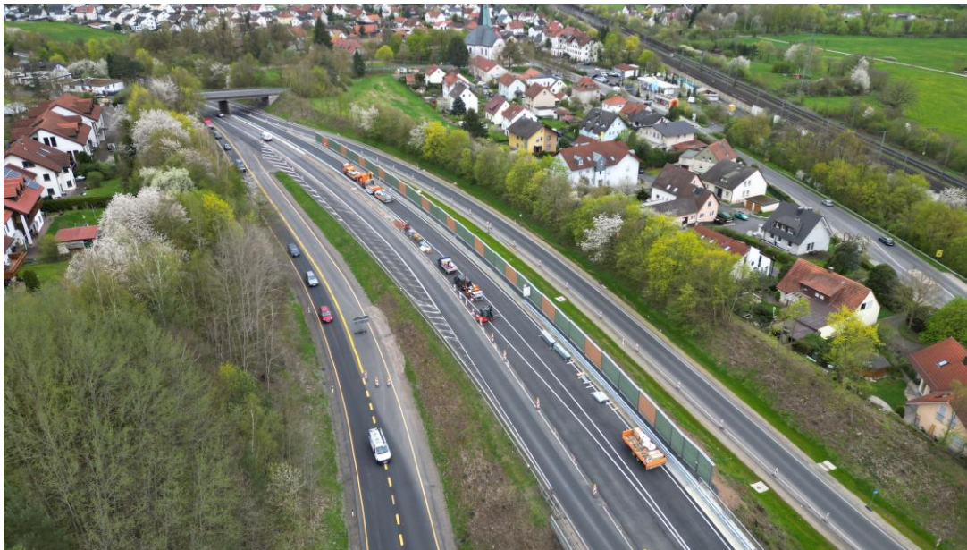
Abbildung 14: Neue westliche Lärmschutzwand im Zuge des Umbaus Bronnzeller Kreisels [Quelle: Hessen Mobil]
