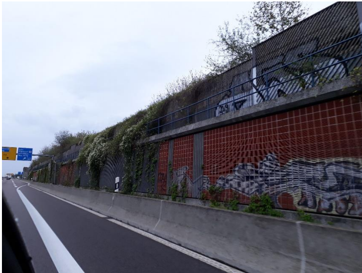
Abbildung 2: Lärmschutzwand [Quelle: RP Darmstadt]
