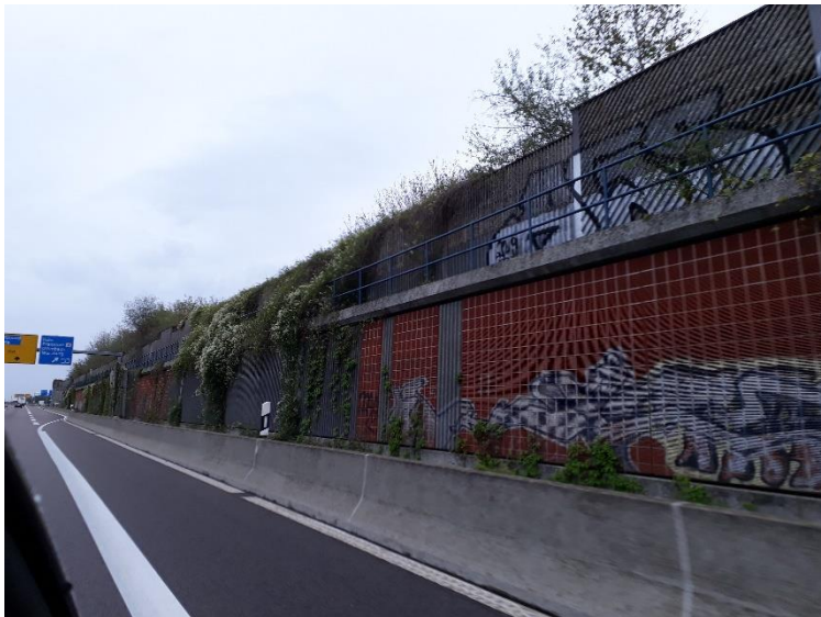
Abbildung 2: Lärmschutzwand [Quelle: RP Darmstadt]
