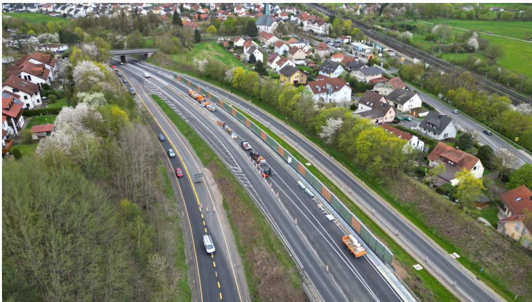
Abbildung 14: Neue westliche Lärmschutzwand im Zuge des Umbaus Bronnzeller Kreisels [Quelle: Hessen Mobil]
