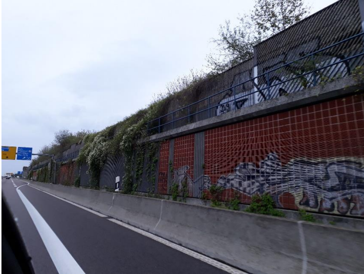
Abbildung 2: Lärmschutzwand (Quelle: RP Darmstadt)
