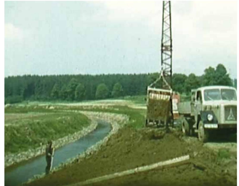
**Maßnahmen des Wasserverbandes Schwalm zur Abflussregulierung und zum Hochwasserschutz in den 1960er-Jahren: Unter anderem im Zusammenhang mit dem Bau des Hochwasserrückhaltebeckens Heidelberg (1965–1968) wurde das Gewässer Schwalm »hydraulisch günstig« und technisch ausgebaut, weil damals vor allem der schnelle Abfluss des Wassers gewünscht war. Foto: Wasserverband Schwalm**
